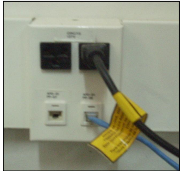
Figura 07- Exemplo de caixa com 02 tomadas tripolares e 02 pontos para internet.
